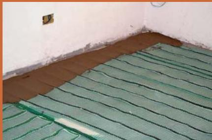
Fig.2 - rasatura procedendo dai bordi in modo da bloccare e stendere completamente i tappetini. In questo caso si è usato Nivorapid di Mapei
