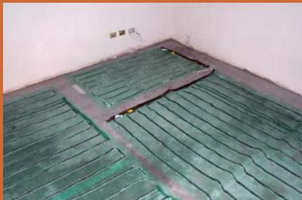
Fig.1 - posa dei tappetini di thermatile direttamente su solaio e collegamento degli elementi tra loro e al cavo di alimentazione - prima di procedere alla rasatura controllare il funzionamento di tutti gli elementi
