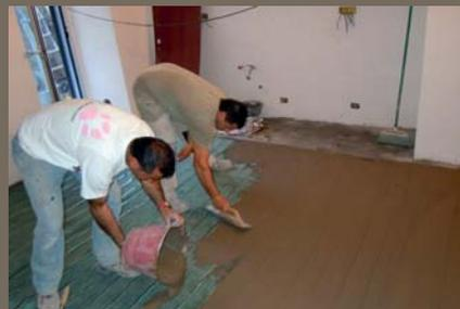
Fig.4 - posa del pavimento Zelo 5 di Del Conca da 5 mm di spessore
