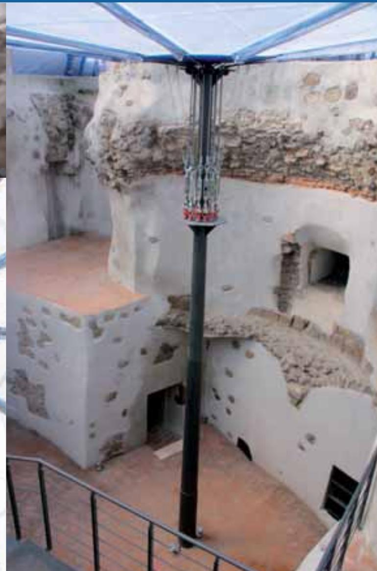
formelle di cotto di diversi formati, e destinato ad enfatizzare ancora di più la presenza del fusto di sostegno della copertura e della nuova scala circolare di accesso al secondo livello, realizzata anch'essa in ferro.
