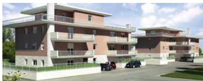
60 FOCUS IMMOBILI De.Luma Costruzioni, AlfaOmega Costruzioni, Cantiere Fiorentino, Cantiere Gubbio, Edil car, Edil Massimina, Ica
